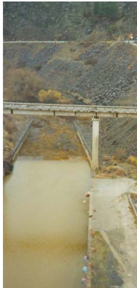
Tramo al pie de la Presa de El Vado (río Jarama). Diciembre de 2000.
