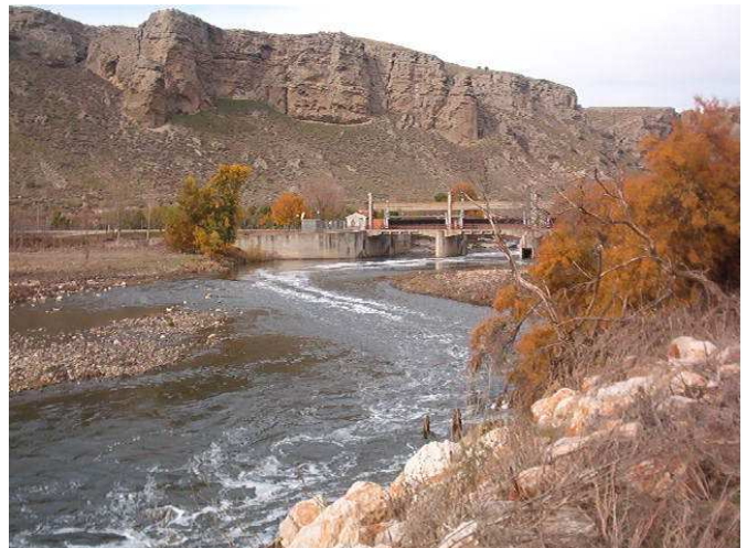
Presa del Rey, junto a la desembocadura del Jarama y el Manzanares. Desde este punto se derivan las aguas para el riego, por el canal Real del Jarama (a la izquierda de la foto)
