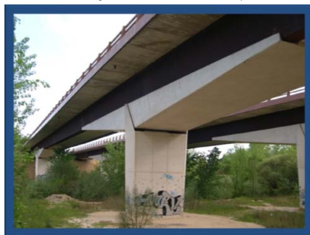
Carretera M-505 a su paso por el río Guadarrama (Las Rozas)
