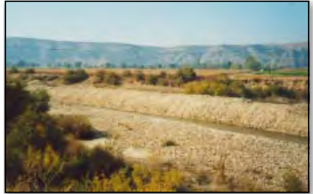
Canalización del río en Velilla de San Antonio. Bajo la excusa de proteger el cauce la Confederación Hidrográfica autoriza este tipo de actuaciones.
