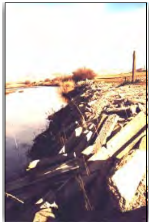
Vertido de vigas de hormigón para canalizar el río
