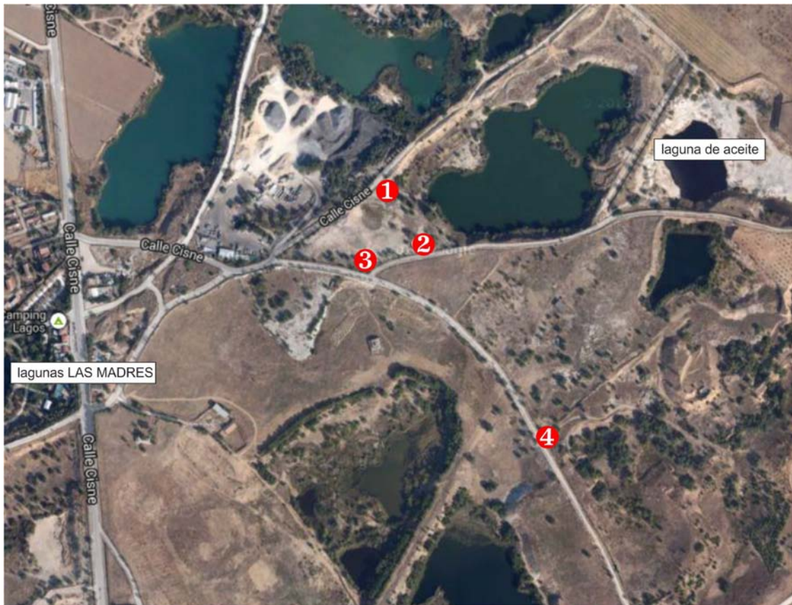
Puntos 1,2 y 3 acumulaciones de basura y residuos listos para su retirada. Punto 4 acceso en la protección de tierra por donde se producen vertidos clandestinos.
