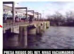
PRESA RIEGOS DEL REY, RIVAS VACIAMADRID
