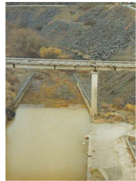
Fotos tomadas desde el muro de la presa.
