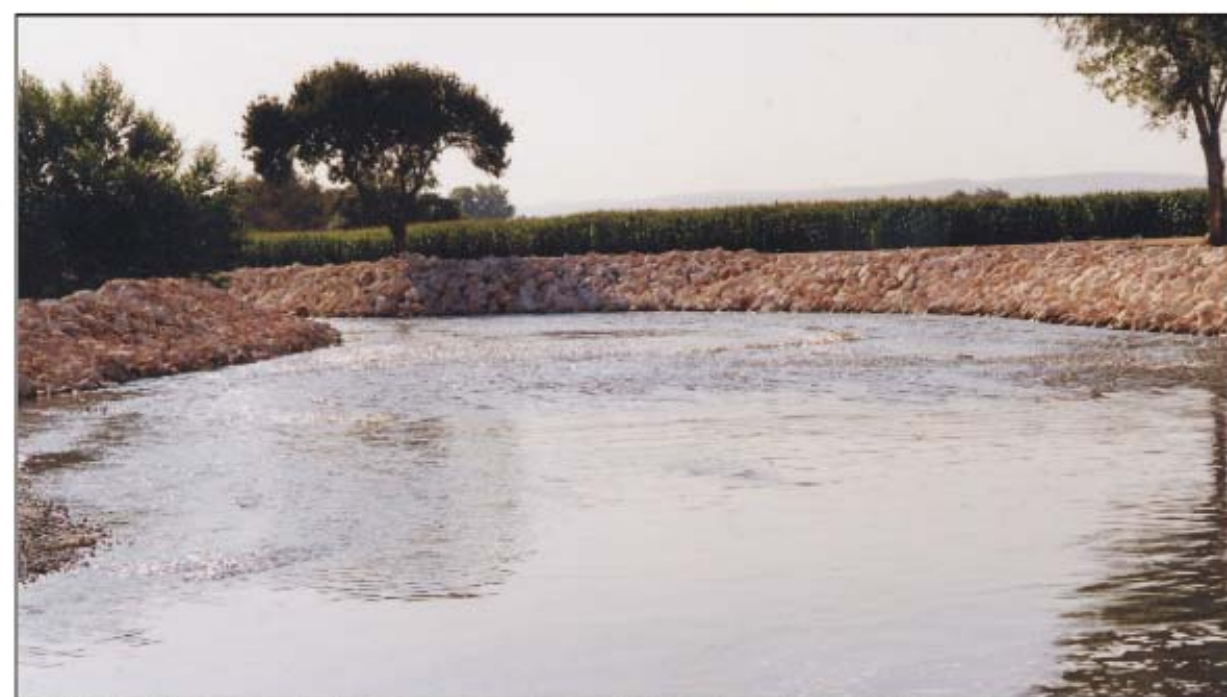
Escolleras promovidas por la Consejería de Medio Ambiente de la Comunidad de Madrid en el tramo bajo del río Manzanares (Parque Regional del Sureste).
